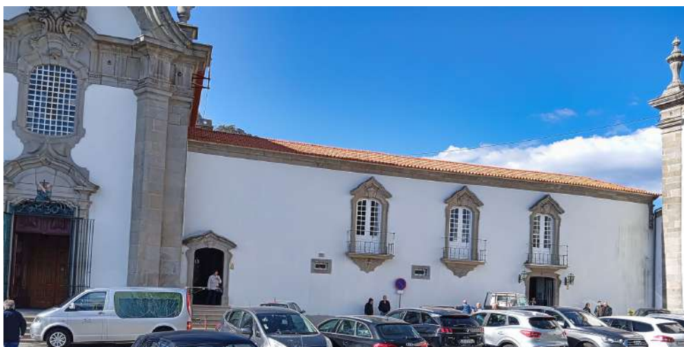
Viana do Castelo. Casa do Despacho da Ordem Terceira Franciscana. 1765-1766
