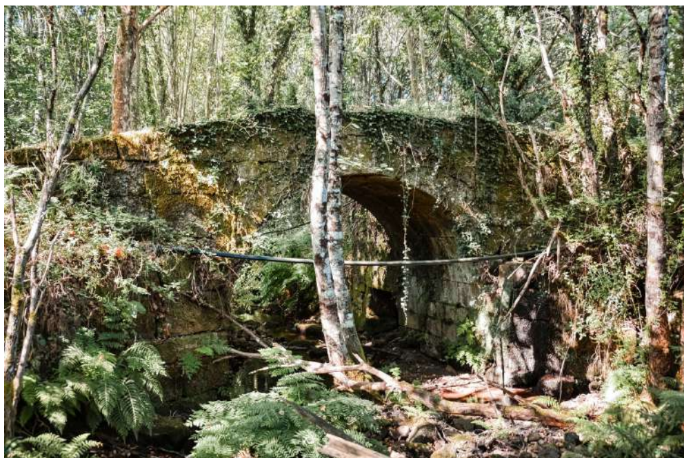
Cabeceiras de Basto. Ponte do Rugido. 1736
