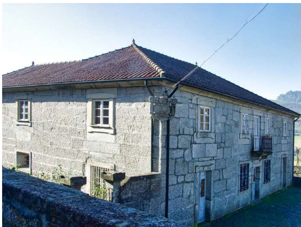
Vieira do Minho. Residência paroquial de Mosteiro. 1748
