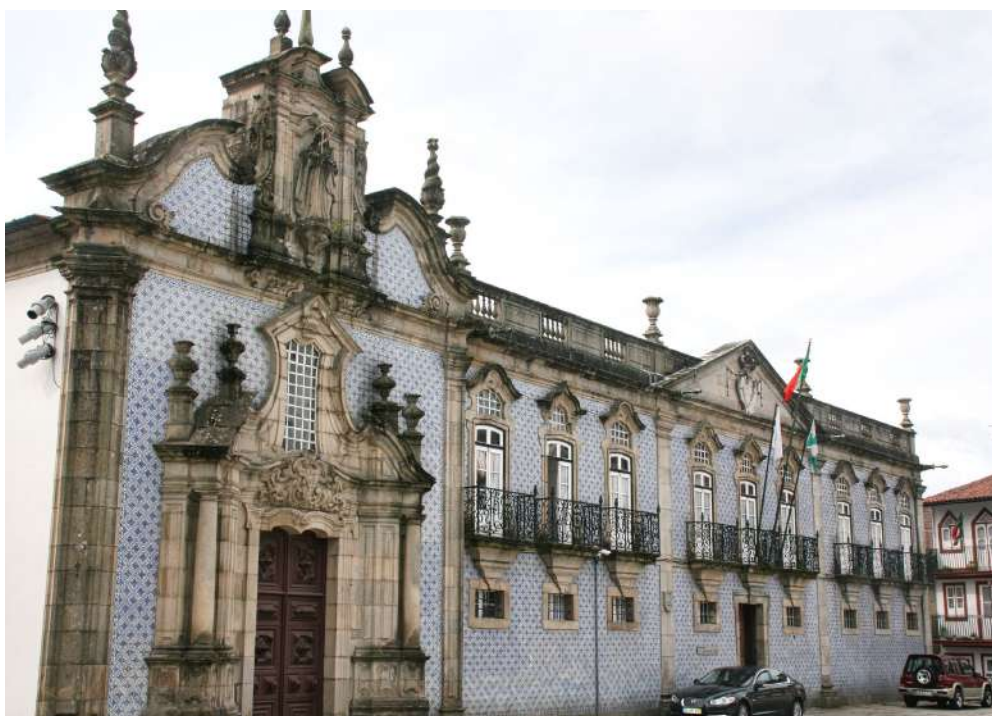
Guimarães. Casa do Despacho da Ordem Terceira de S. Francisco. 1770
